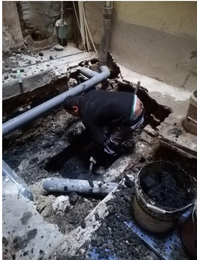
Fig 4 Detall de les tasques d'excavació manual
