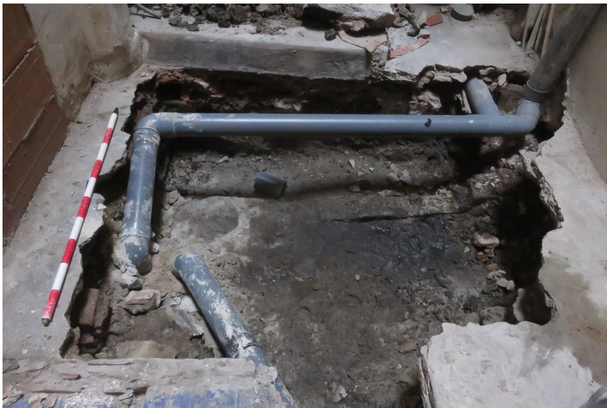
Fig 6. A la imatge superior vista del forat de l'ascensor un cop desviats tots els serveis. A la imatge inferior detall de la fossa UE 04 i l'estrat UE 05 un cop excavats.
