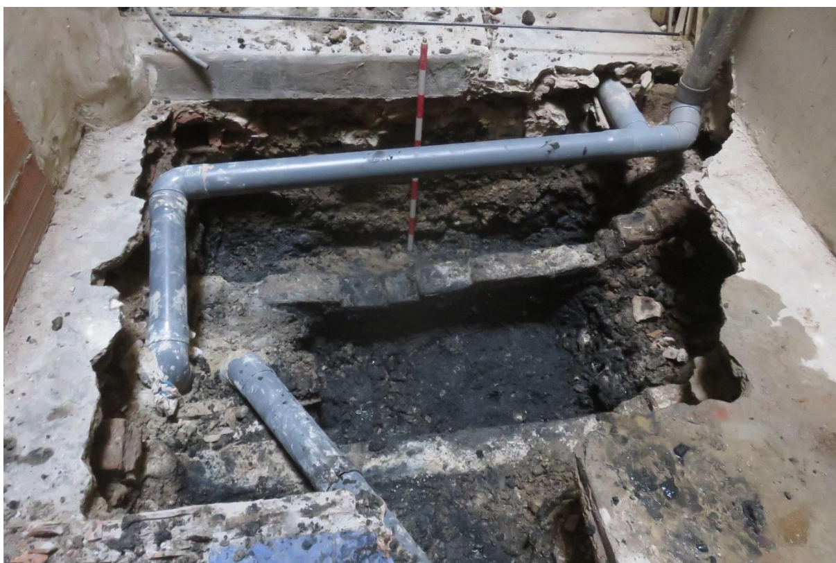
Fig 6. A la imatge superior vista del forat de l'ascensor un cop desviats tots els serveis. A la imatge inferior detall de la fossa UE 04 i l'estrat UE 05 un cop excavats.
